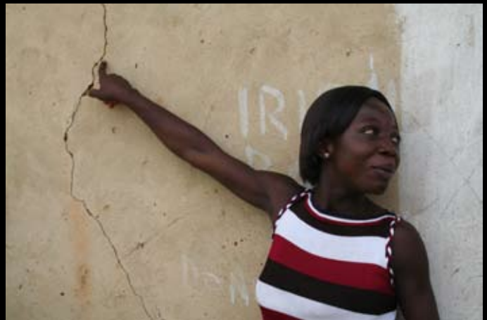
Gruveselskapet iverksetter daglige eksplosjoner for å løsrive stein som inneholder gull. Under eksplosjonene rister jorda i de omkringliggende områdene. Nesten alle bygninger i Terebie har sprekker.
